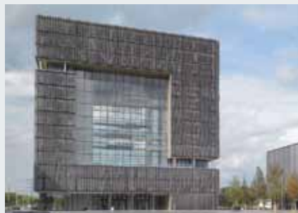
Главный офис компании ThyssenKrupp AG, Эссен
