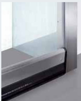
Завеса, плотно установленная в направляющих
